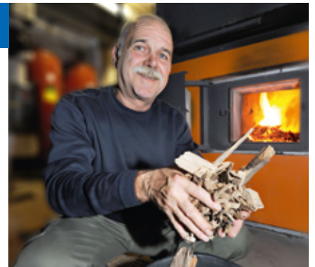
Hausmeister Norbert Weingärtner vor der Holzhackschnittelheizung der Grundschule Pfinztal-Söllingen
